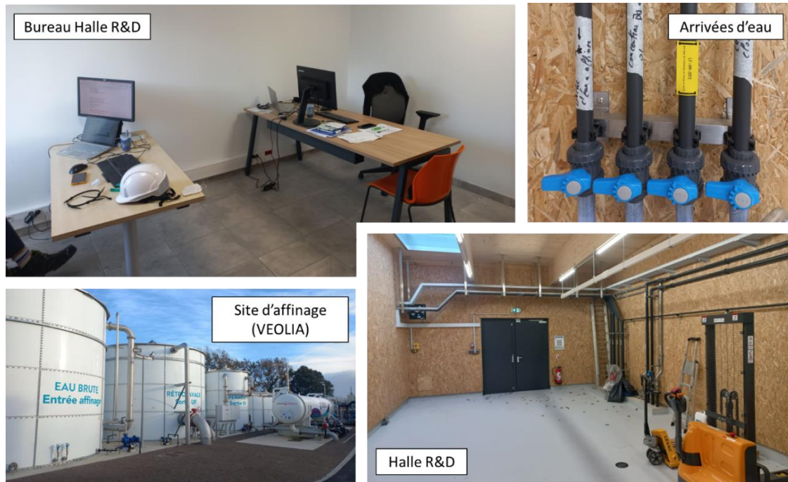
Figure 1 : Hall R&D sur le site d'affinage (construction non finalisée)
